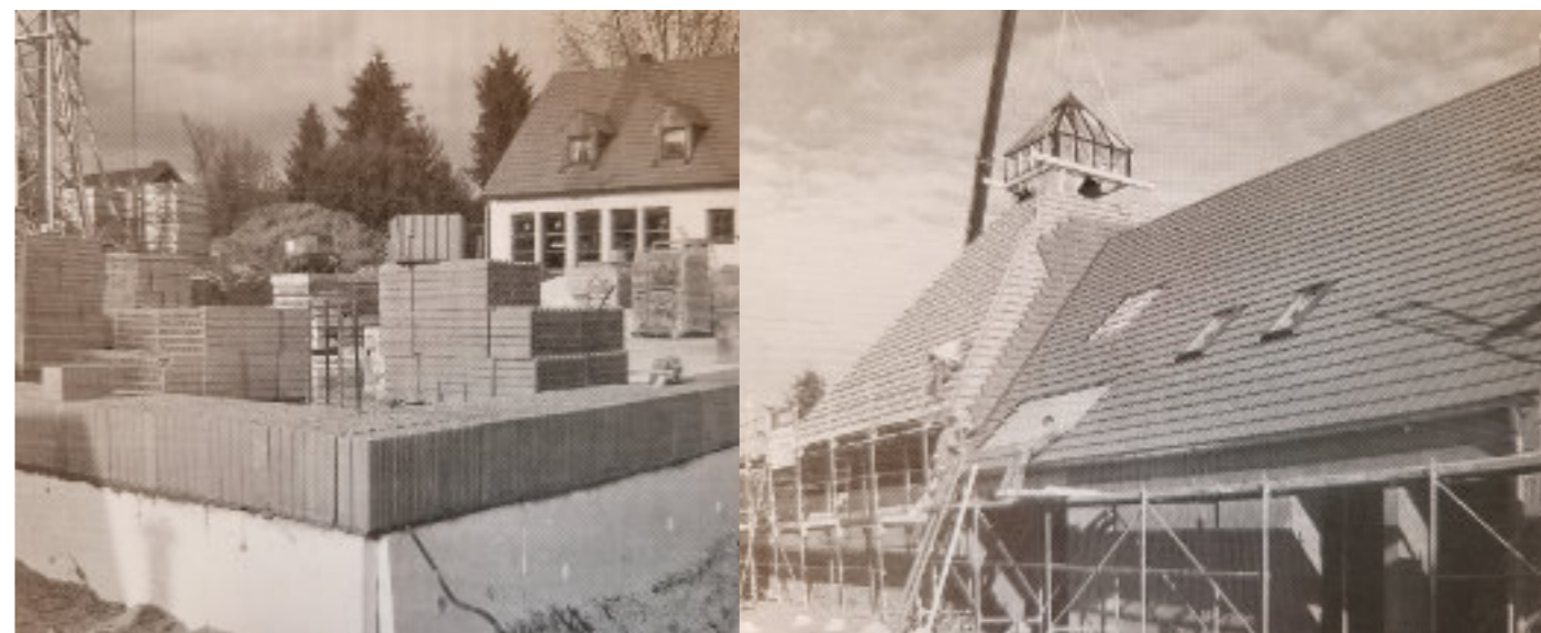
Die evangelische Martin Luther Kirche im Bau, links: beginnen die Bauarbeiten am Erdgeschoss, rechts: wird die Dachlaterne eingesetzt.
